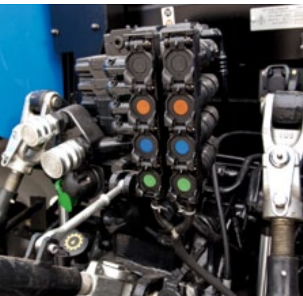
▲ 4x DW met doorstroomregeling in de cabine.
