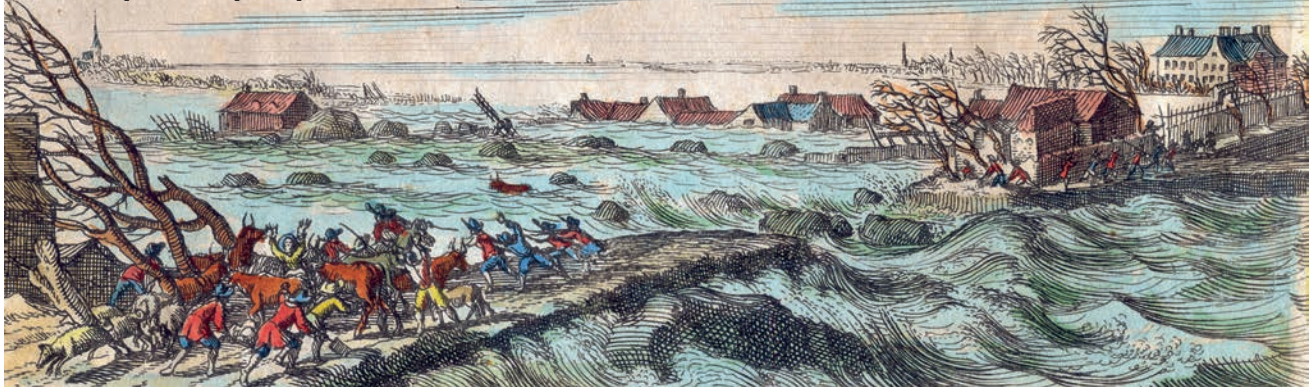
Afbeelding 1. Overstroming van 1675, doorbraak in de zuidelijke IJdijk. Huizen op duinen, dijken, huisterpen en op de polderbodem geven verschillende niveaus van bescherming.
