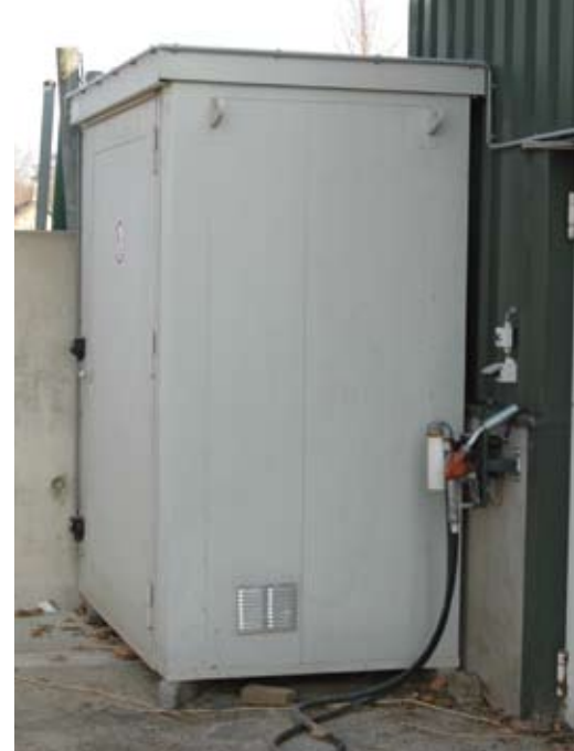
Grote kast voor buitenopslag benzine: geventileerd!
