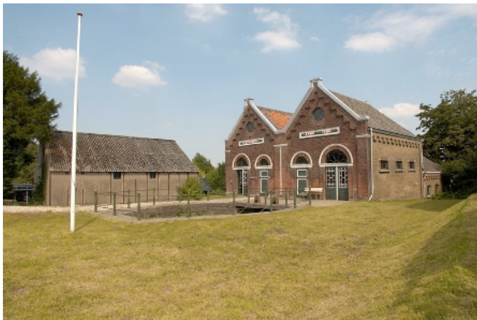
HET MONUMENTALE GEMAAL VERDOOLD (FOTO: HHSK)
