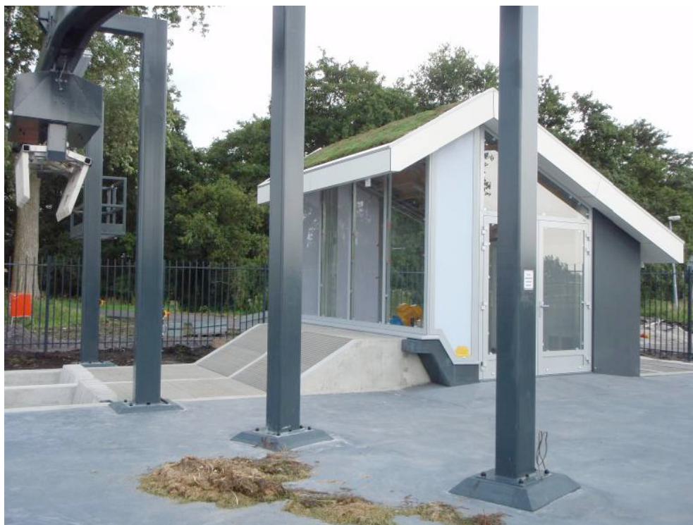
GEMAAL HILLEKADE (FOTO: KOEMAN EN BIJKERK)
