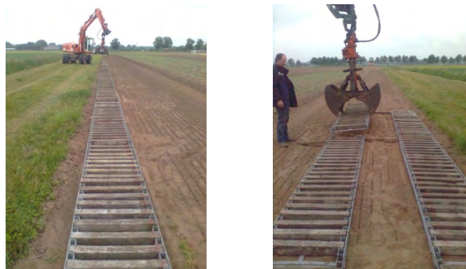
Figuur 1. Aanleg hobbelbaan voor het meten van spuitboombewegingen.
