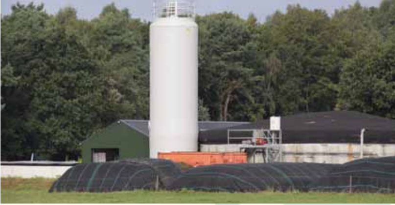
V.l.n.r. (Stukje) sleufsilo voor opslag dikke fractie gescheiden digestaat, loods met hydrolysevat, de staande vergister met daarachter de silo voor de digestaat en voor de silo de mestscheider op een plateau.
