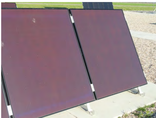
Foto 3: dunne film silicium panelen van Schott
