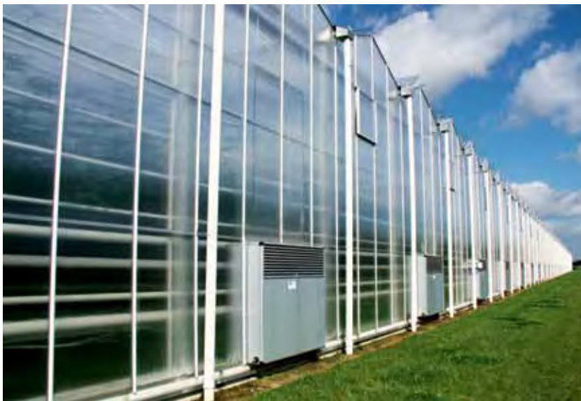
Luchtbehandelingskasten in gevel
