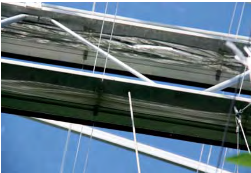
Dubbel scherm; een goede combinatie met luchtbehandeling
