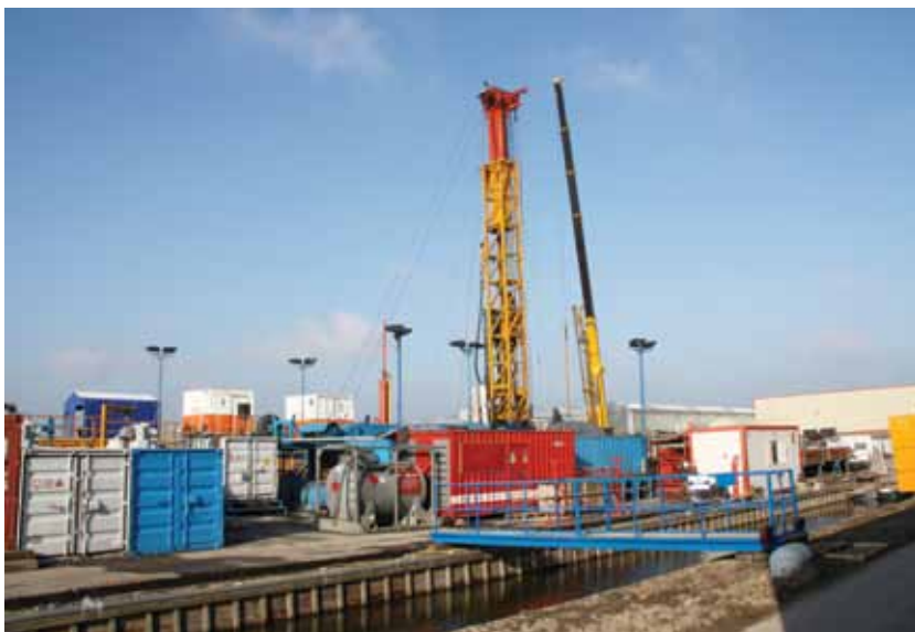
Boren naar aardwarmte op een glastuinbouwbedrijf
