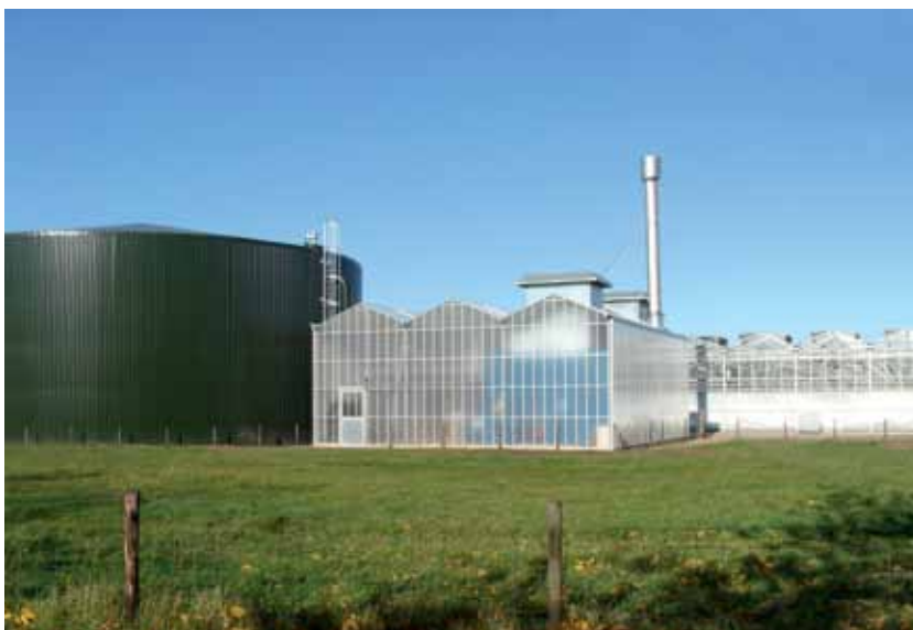
Warmtekracht installatie met warmtebuffer
