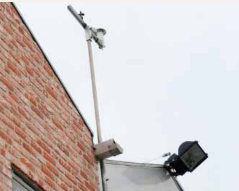
Weerstation met klimaatcomputer verzorgt de ventilatie
