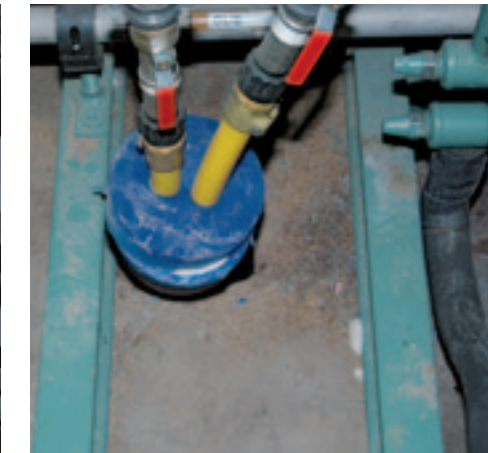
▲ Bij een systeem met restwarmte gaan vanuit de machinekamer twee leidingen naar het huis.
