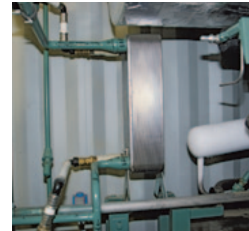
▲ Bij de koeling wordt een warmtewisselaar geplaatst.
