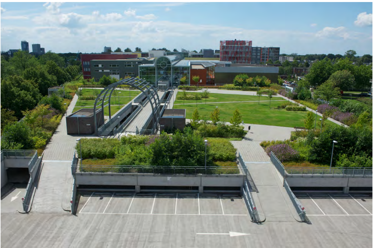
Figuur 15: Een beloopbaar groendak beschermt de dakbedekking.
