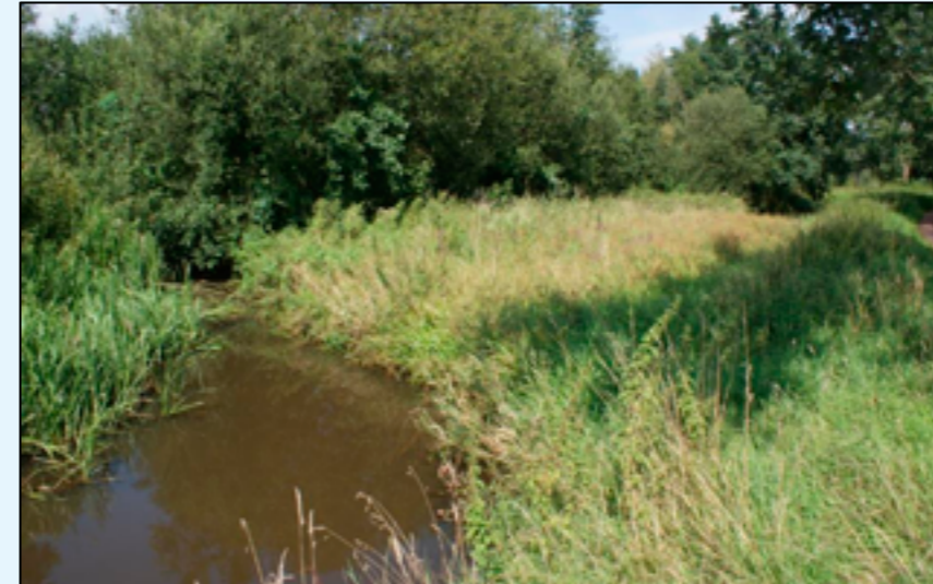
Breed tweefasenprofiel bovenstrooms van 't Ham. Onderhoud gebeurt in een strook van 10 m breed vanaf de wegberm op de rechteroever.
