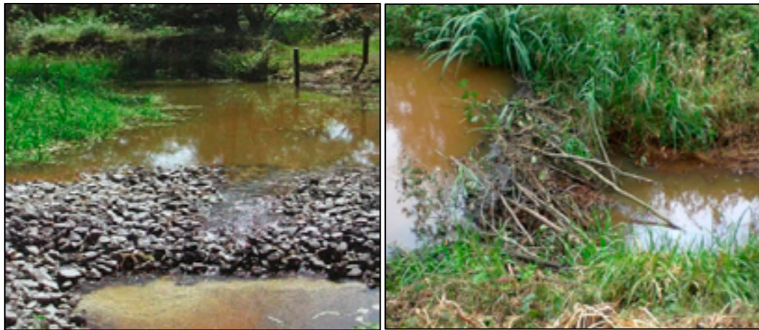
Seminatuurlijke stuwing is oplossing voor ontstuwings, voorkomt insnijding en is passeerbaar voor vissen
