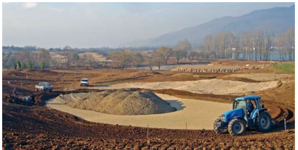
Baanconstructie en beregeningsinstallatie: de constructie en het maken van de 7e green wordt afgerond voor de installatie van de irrigatie.
