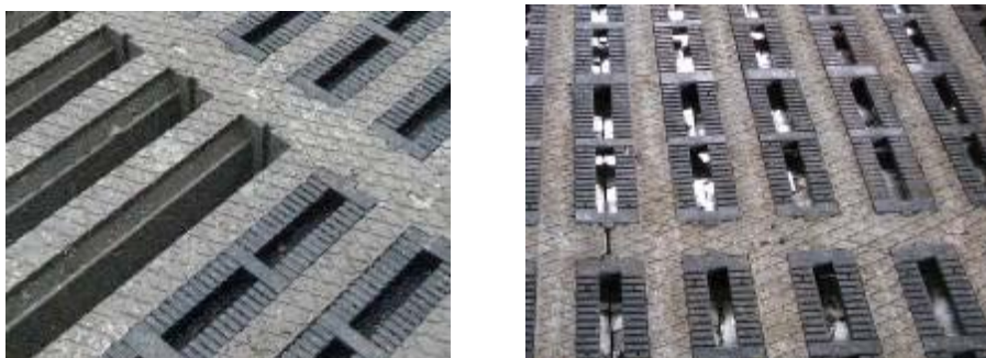
Figuur 3 BWL 2010.34.v1 ( www.infomil.nl ) met de rubercassettes (links) en de kleppen in de cassettes (glimmend, rechts).
