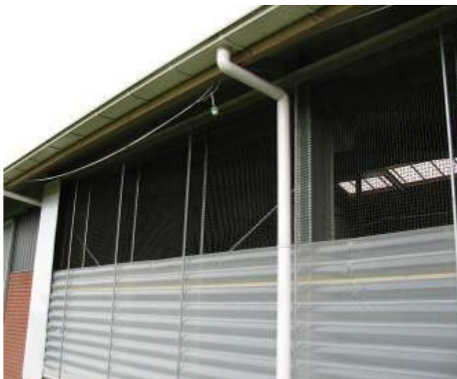
Figuur 2 Inlaatopening zoals die bij normale bedrijfsomstandigheden wordt gebruikt. Het ventilatiesysteem is ongeveer voor de helft opgeblazen.
