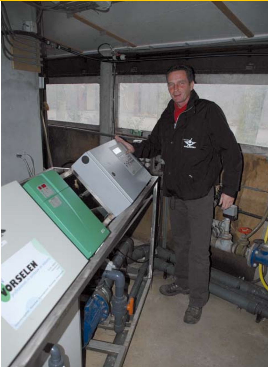
De opgeloste meststoffen worden hier opgemengd met het beregeningswater.
