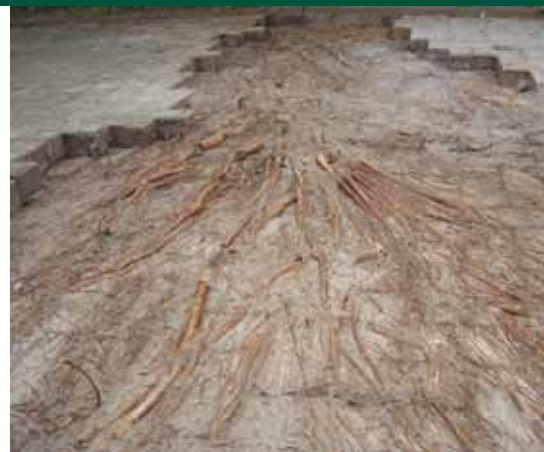
Wortels zitten vaak in de funderingslaag net onder de verharding.
