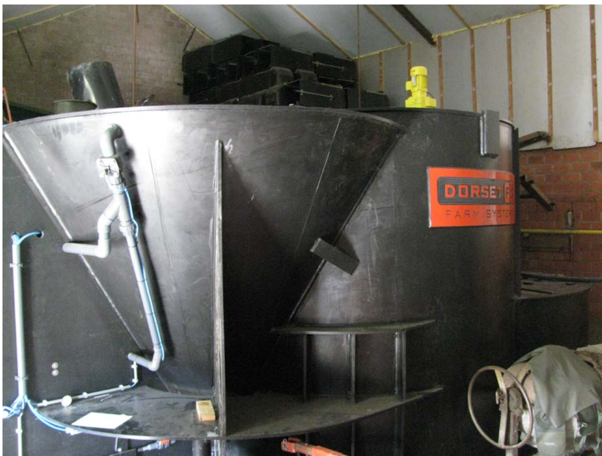
Figuur 3 Denitrificatie-unit van de experimentele biologische luchtwasser met links de trechtersvormige bezinker en rechts de denitrificatie-reactor).
