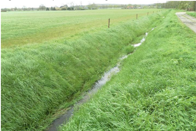
Figuur 10 Homogene steile oever. Het lengte profiel is recht en de oever smal en steil.
