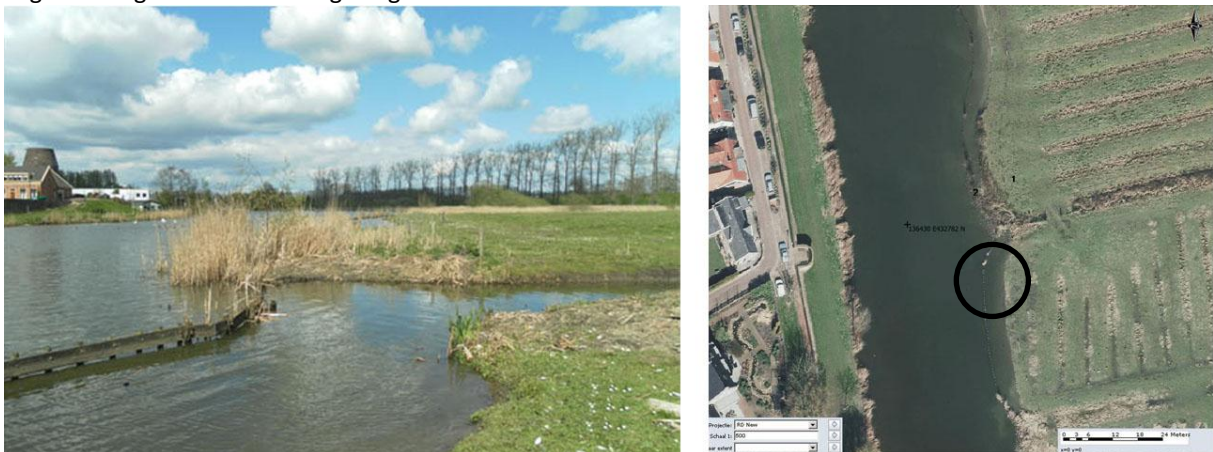
Figuur 13 Heterogene oever met beschoeiing. Het oever profiel slingert, de beschoeiing is op beide foto's te zien.
