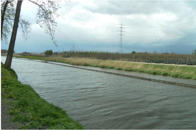
Figuur 9 Homogene oever met beschoeiing. Het lengteprofiel is recht en de beschoeiing op beide foto's duidelijk te zien.
