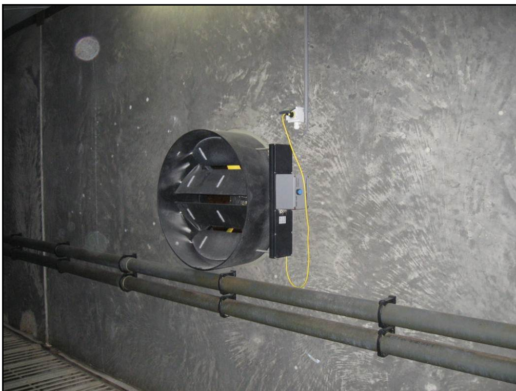
Luchttuitlaat stal naar centraal afzuigkanaal
