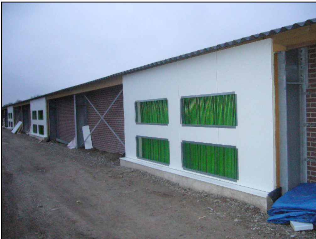
Luchtinlaat met warmtewisselaar (LC-units)
