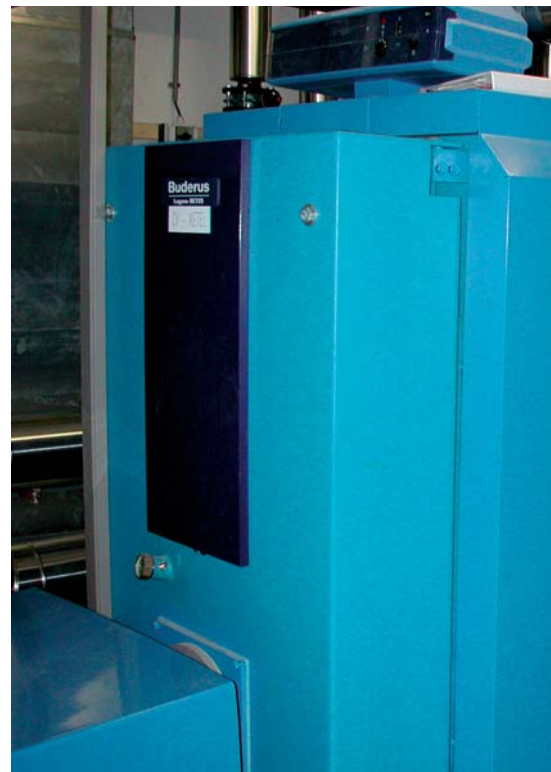
Grote CV-installatie gebruikt bij weinig warmtevraag re
