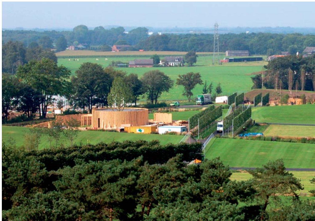
Een blik vanuit de kabelbaan op het themaveld Education & Innovation met links van het midden het in aanbouw zijnde boomkwekerijpaviljoen en rechts daarvan een deel van de leilindes
