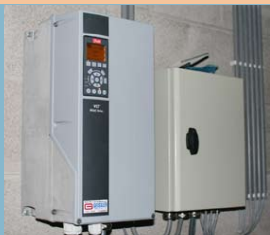
Ten opzichte van de voorheen gangbare triacregeling is met een frequentieregelaar een elektriciteitsbesparing tot 70 procent mogelijk.
