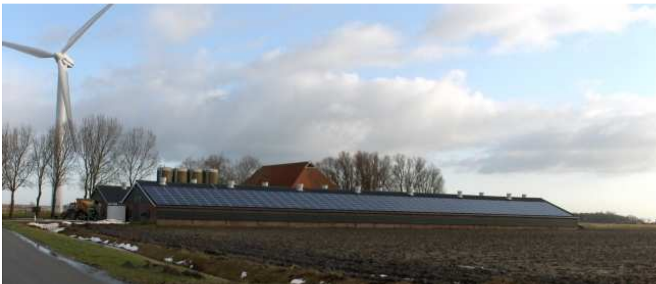
Figuur 4 Vleeskuikenstal met PV-panelen
