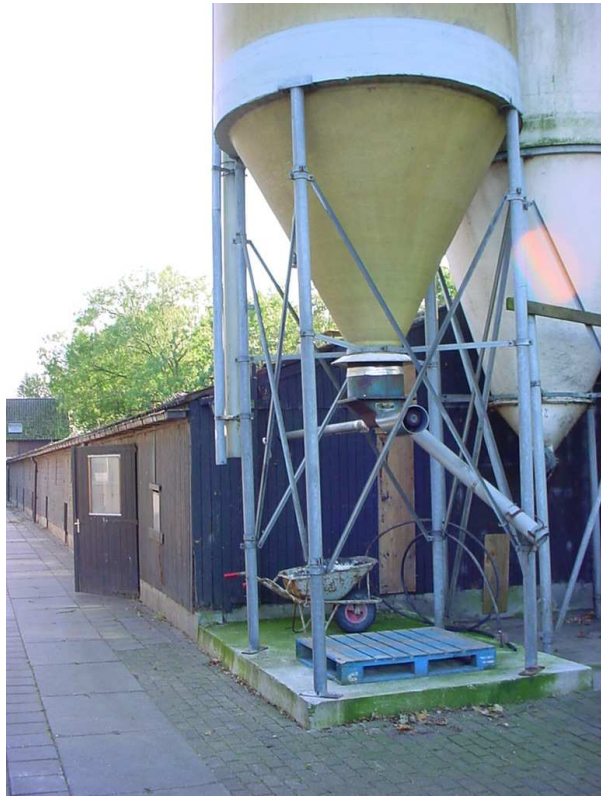
Figuur 1 en 2: Een biomassa gestookte cv-ketel is niet veel groter dan een cv-ketel. Voor de opslag van biomassa wordt veelal gebruik gemaakt van (gebruikte) voersilo's met starre aanvoervijzel
