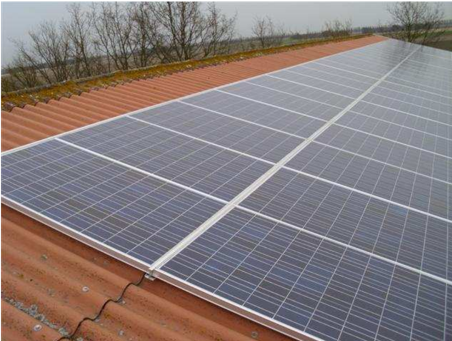
Figuur 1 Toepassing van harde PV-panelen op een bestaand dak.
