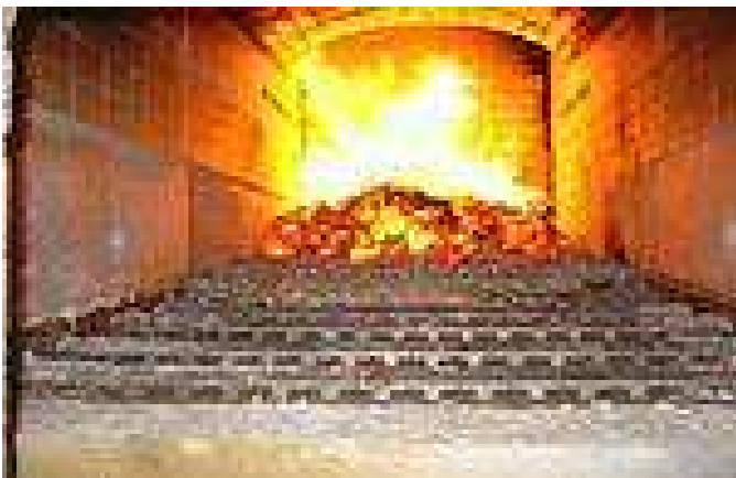
Figuur 3 en 4: Biomassa cv-ketels met een zogenaamd vlakroosterverbrandingssysteem zijn geschikt voor de verbranding van biomassa in de range van stof tot suksgruotte van 300 mm en van droog tot 50% vocht. Tevens is het geschikt voor de verbranding van afwijkende brandstoffen met een hoog as-gehalte (o.a. zandresten). Door de langzame invoer van de biomassa en de speciale warmtewisselaar, is een laag stofgehalte in de rookgassen mogelijk.
