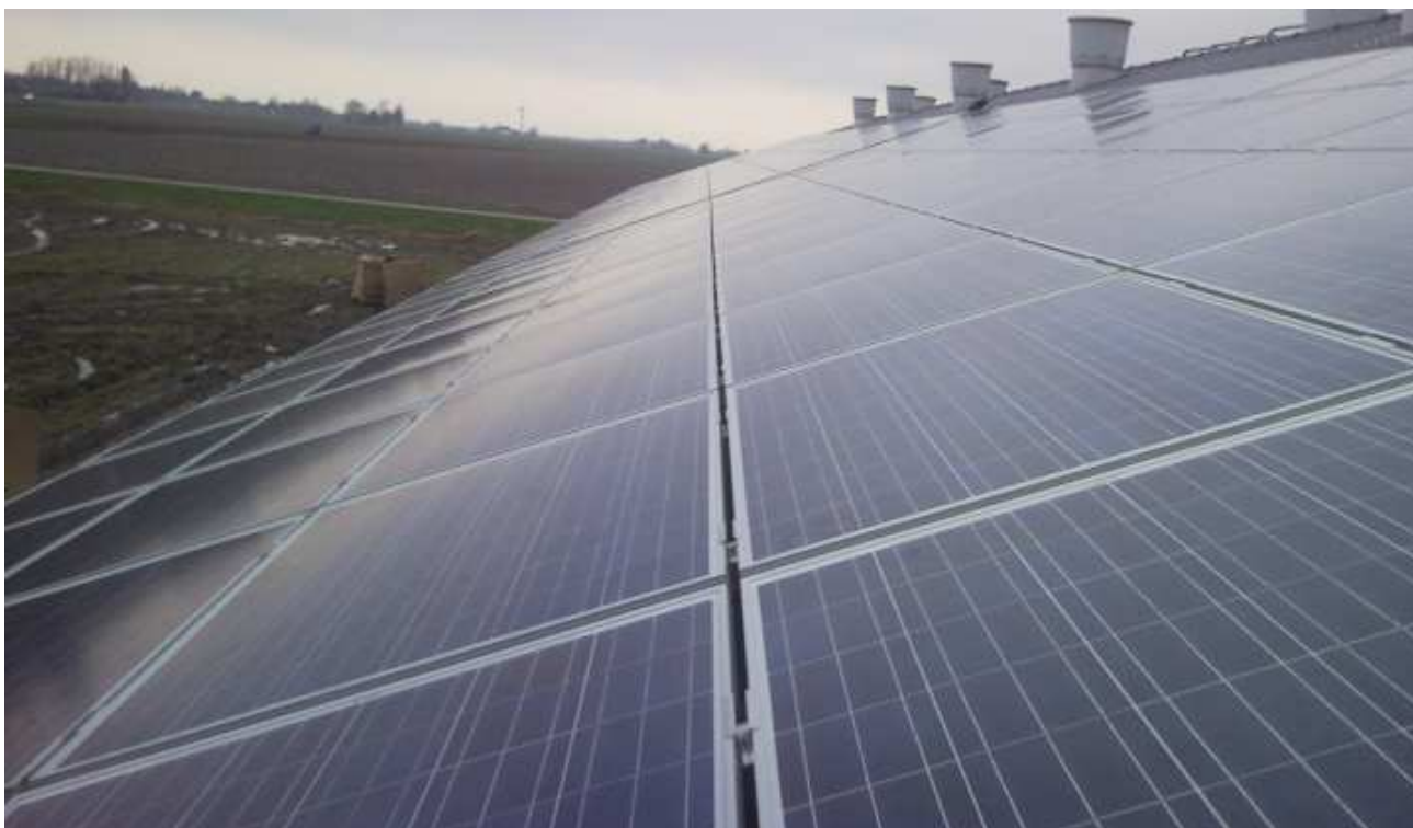
Figuur 4 en 5 Toepassing van 350 PV-panelen (525 m 2 ) met een vermogen van 70 kWattpiek op een vleeskuikenstal. Productie ca. 40.000 kWh elektriciteit per jaar.
