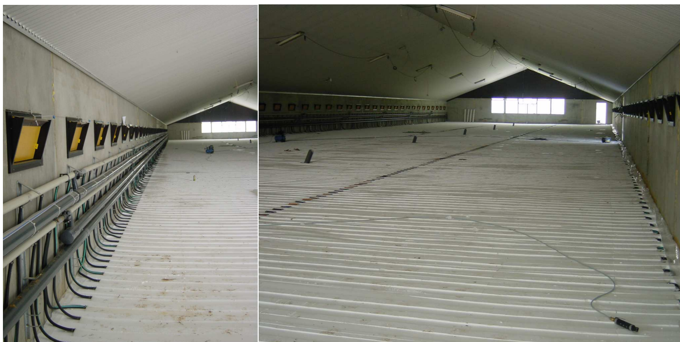
Figuur 2. Aanleg van vloerisolatie met daarin verwerkt kunststof warmtewisselaarelementen om via wateroverdracht van warmte of koude naar de vloer van een vleeskuikenstal mogelijk te maken in het kombideksysteem. Op de isolatie wordt een betonnen afwerkvloer gestort.
