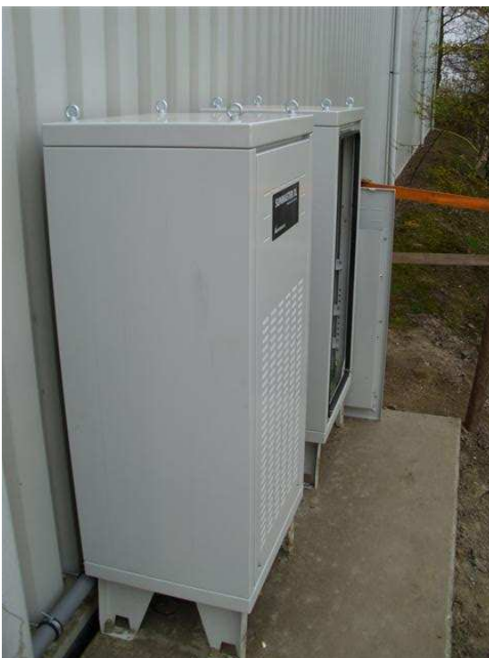
Figuur 2 De opgewekte stroom in PV-panelen wordt in een omvormer omgezet naar wisselspanning met 220 volt. De omvormer staat dicht bij de PV-panelen. Vanaf de omvormer wordt er een aparte voedingskabel naar de meterkast geplaatst om via een netto productiemeter de stroom te leveren aan het eigen bedrijf of op het net.
