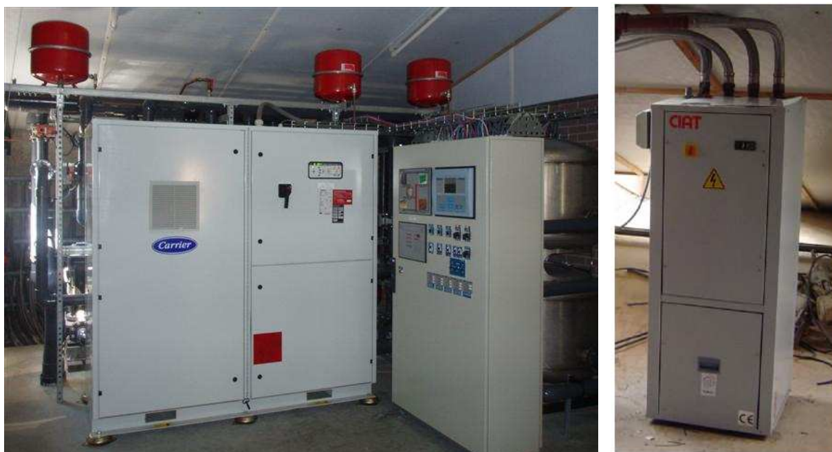
Figuur 3: Links een warmtepomp van 200 kWth en rechts van 60 kWth. Bij de toepassing van grote warmtepompen rekening houden met een zwaardere netaansluiting.
