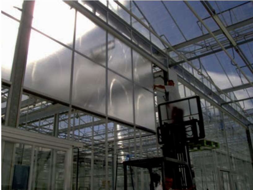
Figuur 3. Het diffuse glas heeft een structuur die het licht diffuus maakt en het glas een melkachtig uiterlijk geeft. De foto laat het verschil zien met het standaardglas tijdens het verdekken in augustus 2010.
