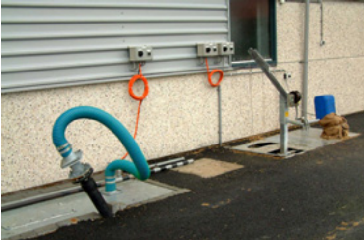
Foto 7: Links de navergister waar de vergiste mest afkoelt voordat het naar de opslag onder de stal wordt gepompt. Rechts de voormengput met pomp en dompelmixer.
