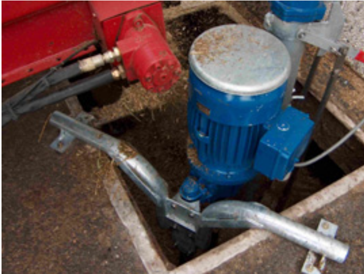
Foto 4: Vanuit de opraapwagen wordt het in de voormengput gedraaid waar het gemixt wordt met mest en tenslotte door de pomp (blauw) naar de vergister gepompt wordt.
