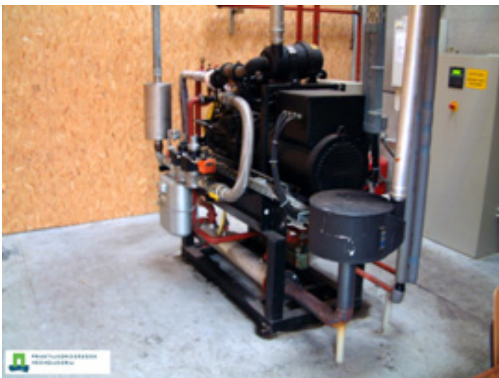
Foto 6: De Warmte Kracht koppeling (WKK)
