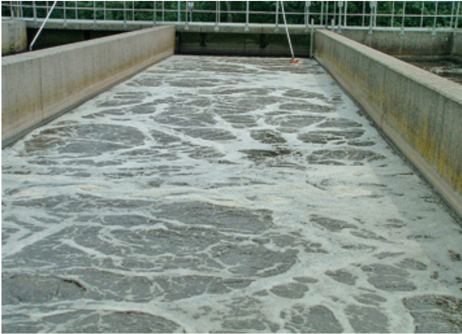
Beluchtingstank met meetsensor.
