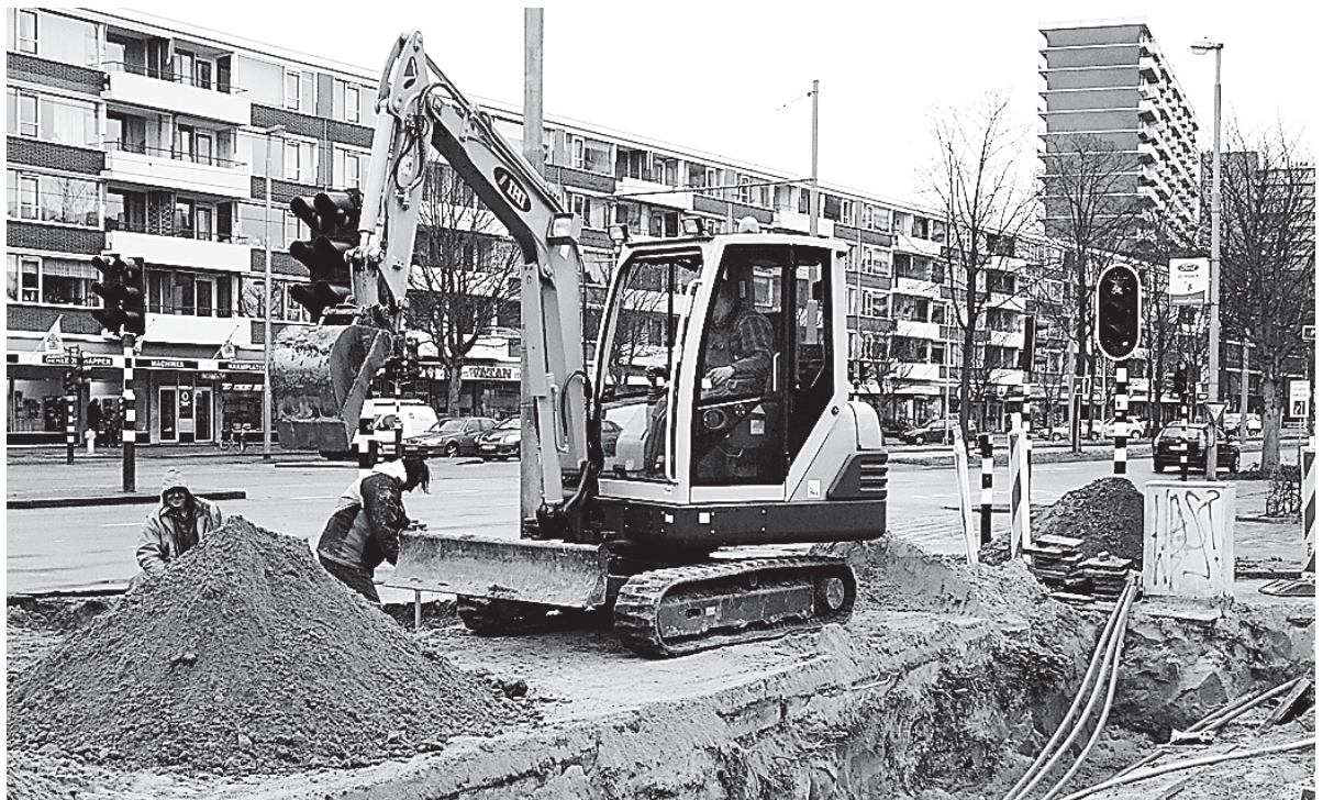
Ook in de Papsouwselaan liggen rioolbuizen in de grond. Nu het werk aan de bekabeling (foto) klaar is, komt het riool deze week aan de beurt.
