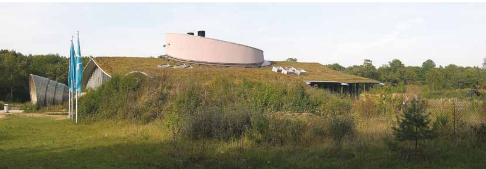
Illustratie 7 Bezoekerscentrum De Hoep in Castricum van architect Maarten Min uit het jaar 1992. Bij dit bezoekerscentrum heeft de beplanting en het substraat een bovengemiddelde invloed op de totale Rc-waarde van de constructie, omdat het oppervlak een groot deel van het gebouw beslaat en omdat de constructieve R-waarde in de tijd dat het gebouw ontworpen is, nog niet zo hoog was als nu gebruikelijk is. De EPC-eis voor woningbouw werd in 1994 verlaagd naar 1,2 [-].
