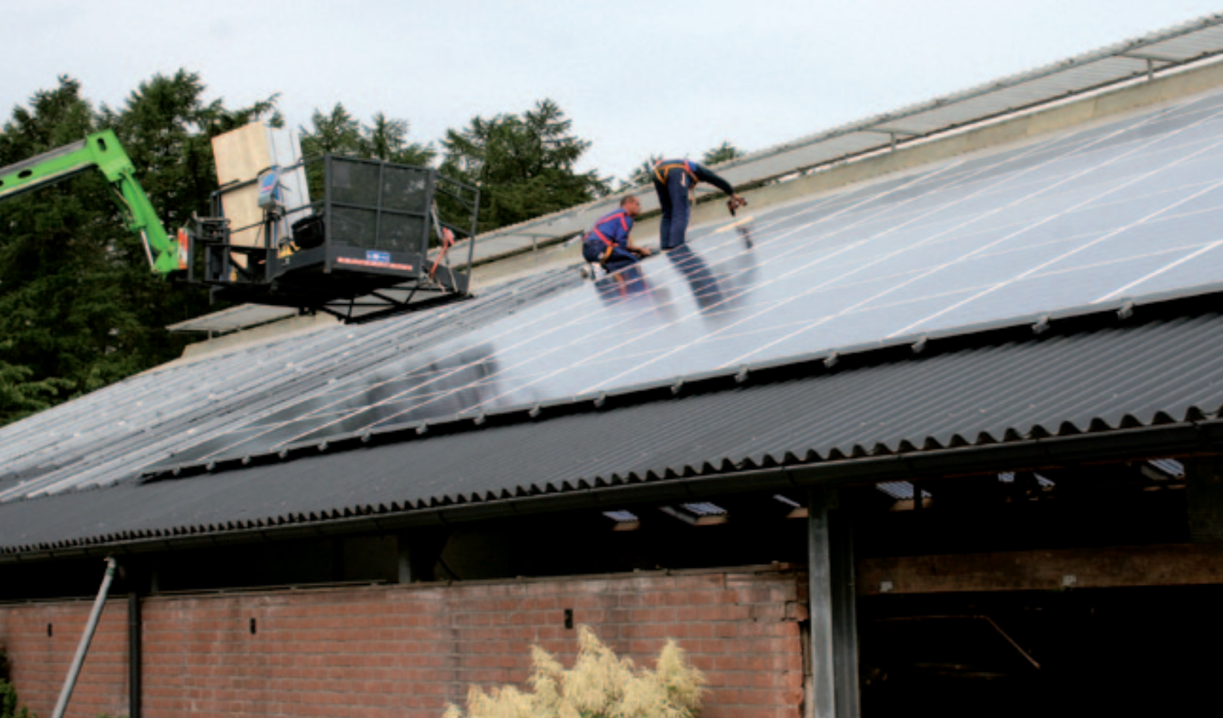
Installateur Morrenhof-Jansen plaatst zonnepanelen op een melkveebedrijf in Dalfsen. Een op de vijf melkveehouders wil investeren in deze alternatieve vorm van energieopwekking.
