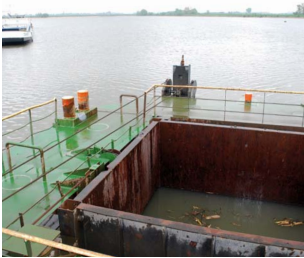
Door gebruik te maken van een stortkoker vertroebelt het water niet.
