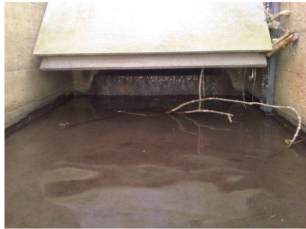
Figuur 4.7.3. Drempel en afsluitklep aan de benedenstroomse zijde van de Hemelbeekduiker onder het Julianakanaal
