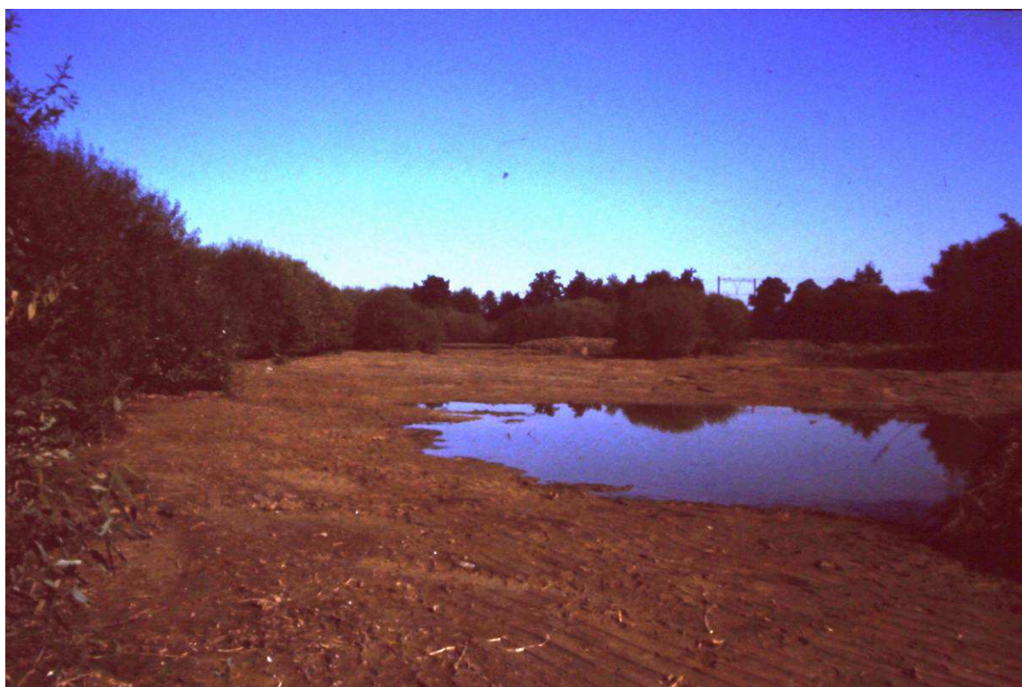
Horsterplas-zuid tijdens het uitvoeren van de baggerwerkzaamheden in 1994-1995.
