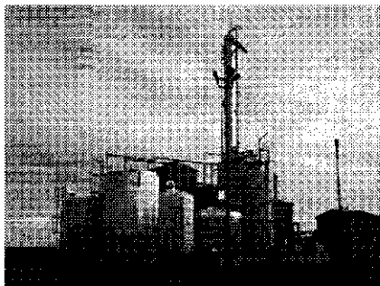
Eerste biotechnologische aardgas ontzwellingsinstallatie Canada (1 ton zwavel per dag)
