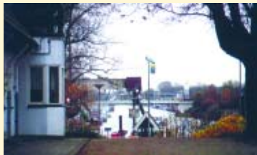
SLUIZENCOMPLEX LANGS DE OOSTZIJDE VAN HENGELO (TWEKKELO)
