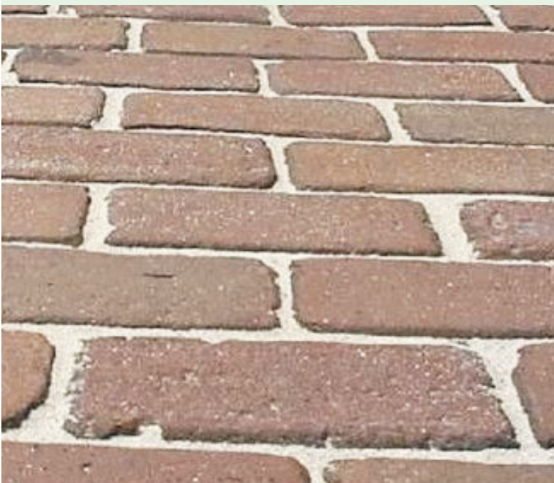
Onkruidwerend voegmiddel tussen bestaande klinkers.
