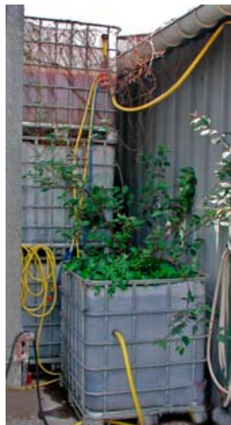
Belangrijkste deel van de biofilters zijn gestapelde containers met een biologisch actief substraat
