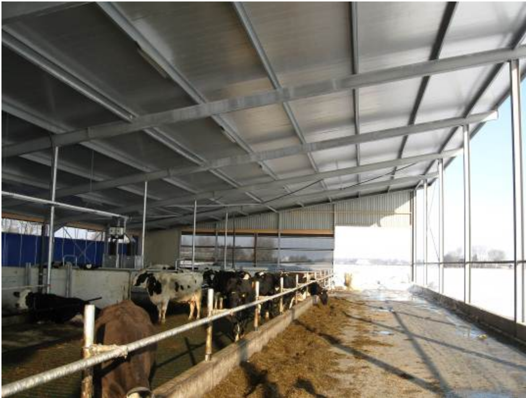
Figuur 1 Overzichtsfoto van de stal. Links op de foto is het blauwe zeil zichtbaar wat de ventilatieopening aan de westzijde van de stal beperkt. De voorzijde van de stal is geheel open en kan ook niet worden afgesloten. De zijwand ter hoogte van de dieren is afgesloten met windbreekgaas. De voergang is op deze foto geheel geopend, tijdens de metingen was deze aan beide zijde afgesloten met een vergelijkbaar windbreekgaas.
