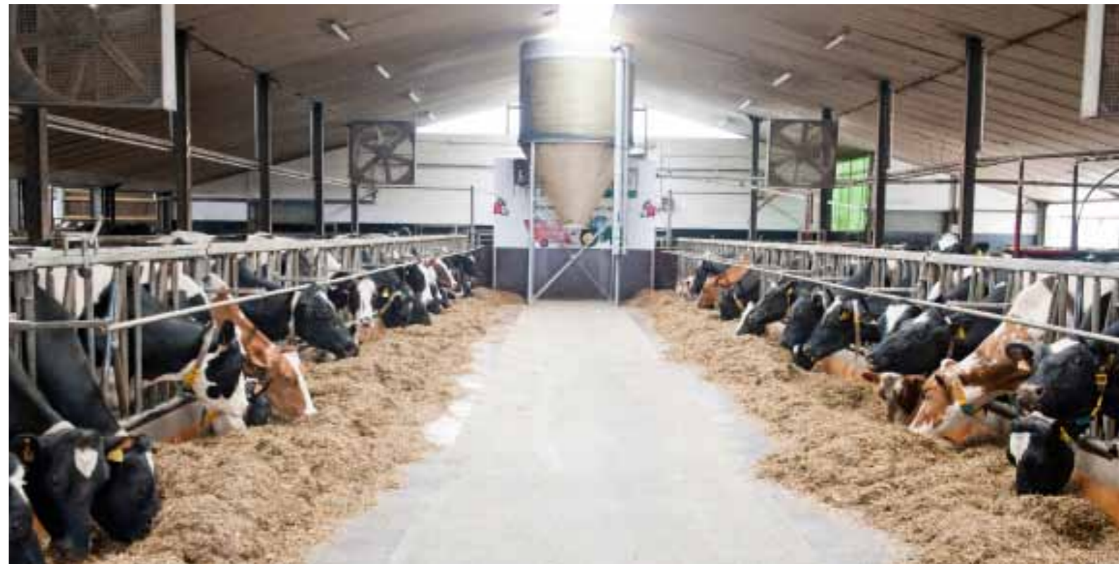
De ligboxenstal telt 145 ligplekken en 144 vreetplaatsen
