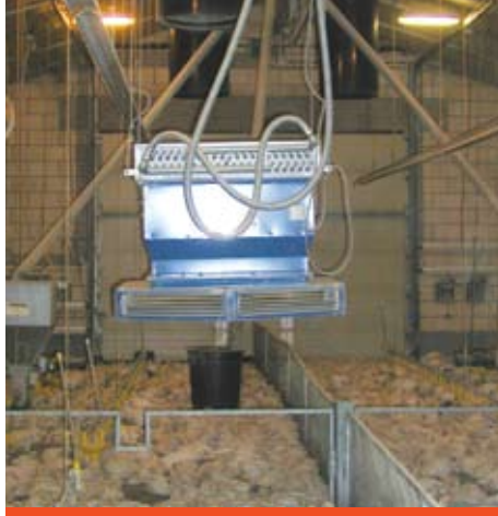
De heater zuigt lucht aan uit de nok van de stal en blaast warme lucht over de kuikens.
