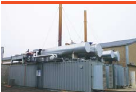
De pluimveestallen worden verwarmd met de restwarmte van de vergistingsinstallatie.
