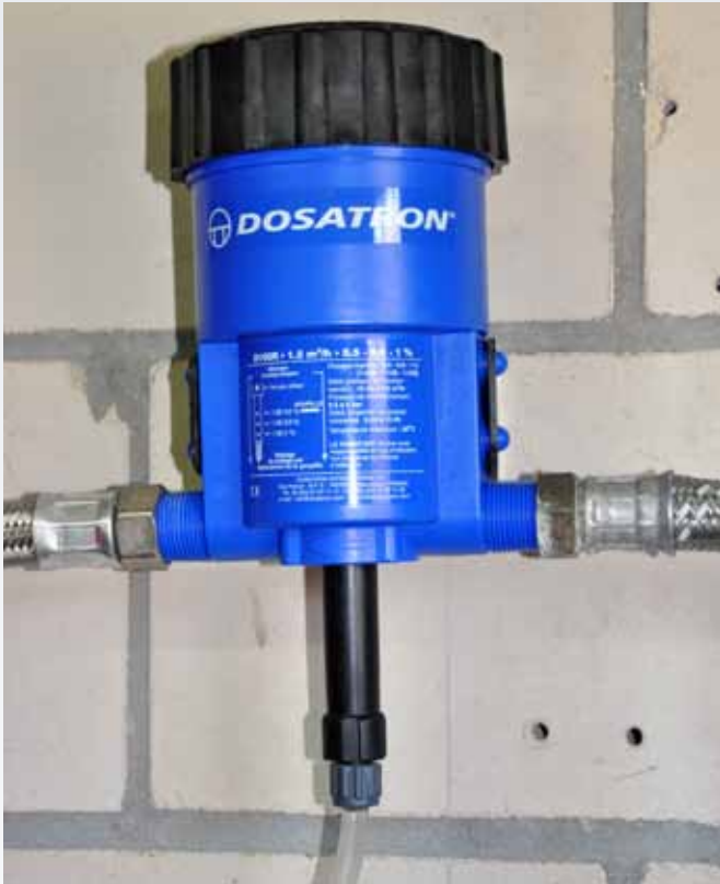
Foto 3: Toevoeging van additieven kan met doseerpompen.
