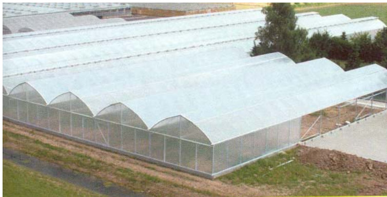
Figuur 19. Voorbeeld van foliekappen met geknikte, gotische dakvorm (Amevo).
