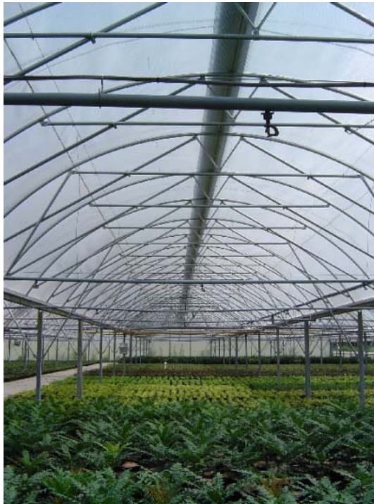
Figuur 61. Multispan rollair foliekas binnenkant (Rovero systems), kwekerij in Opheusden, dak volledig gesloten.
