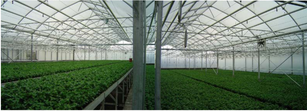
Figuur 53. Multispan foliekas met gotische kap en éézijdige nokluchting binnenkant (Amevo Techniek), kwekerij in Bruchem, dubbel opgeblazen folie in het dak.
