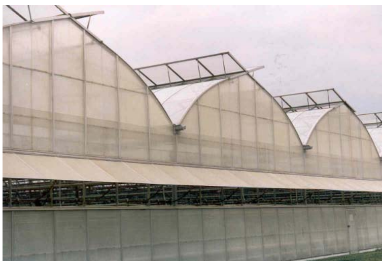
Figuur 29. Voorbeeld van een aanéengesloten foliekas met kappen gedragen door goten (foto Waaijenberg).
