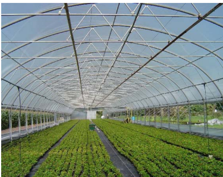
Figuur 73. Folietunnel met zijluchting in Roggel voor het kweken van sierheesters (oorspronkelijk voor het kweken van courgettes gebouwd).
