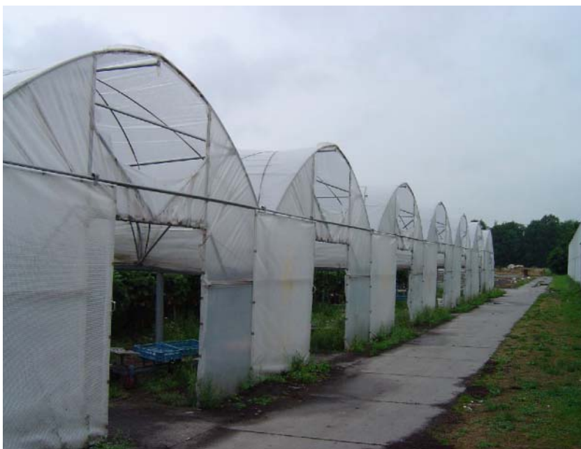
Figuur 47. Verhoogde wandelkappen buitenkant (Amevo Techniek), kwekerij in Dongen; luchting door kopgevels.
