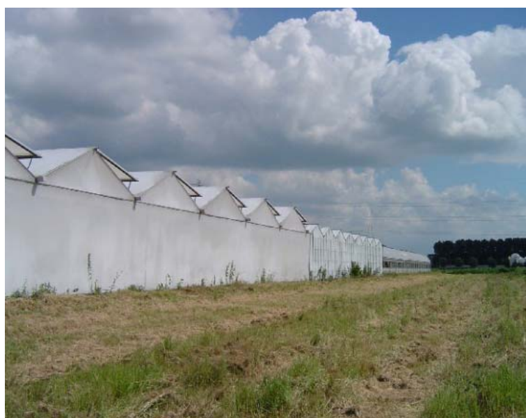
Figuur 58. Multispan foliekas met zadeldak en éézijdige nokluchting buitenkant (VDH), kwekerij in Opheusden.
