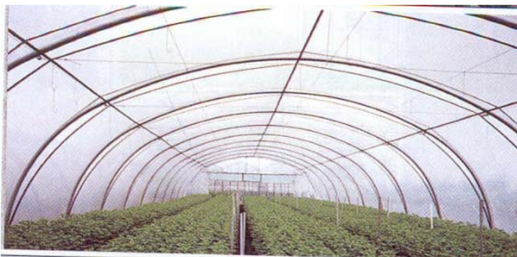
Figuur 9. Binnenaanzicht van een folietunnel met gebogen doorsnedevorm (Rovero).
