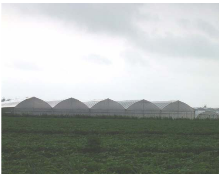
Figuur 52. Multispan foliekas met gotische kap en éézijdige nokluchting buitenkant (Amevo Techniek), kwekerij in Bruchem.
