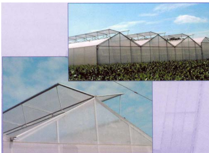
Figuur 30. Foliekassen met zadeldaken en doorlopende nokluchting (als een breedkapper) (VDH).
