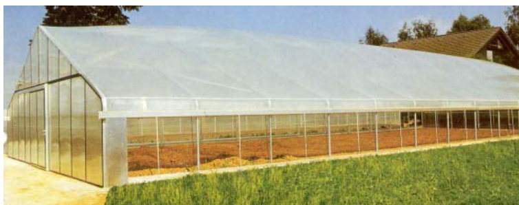
Figuur 20. Een alleenstaande foliekas met zadeldakvorm dubbele, opgeblazen kunststoffolie in het dek en doorgaande zijgevelluchting (Götsch & Fälschle).
