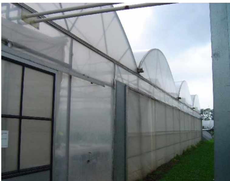
Figuur 56. Multispan foliekas met ronde kap en zijluchting met netten buitenkant (Amevo Techniek), kwekerij in Zaltbommel.
