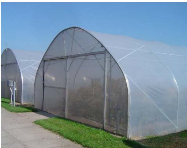
Figuur 71. Gesloten folietunnels voor zaadproductie in Nunhem (Haalen), waarbij ventilatie plaatsvindt door insectengaas in de kopgevels.
