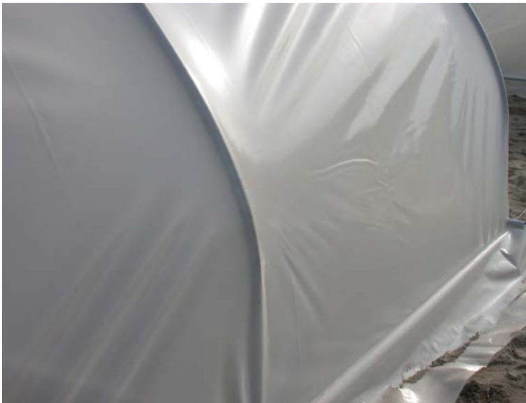
Figuur 45. Door temperatuursinvloed verouderd folie in direct contact met de staalconstructie sneller (zogenaamde hotspots) (Foto Waaijenberg).
