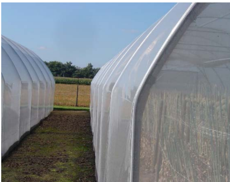
Figuur 72. Insectendichte folietunnels bij zaadproductiebedrijf in Beesel met een verticaal deel van de langsevels en insectengaas in de kopgevels voor ventilatie.
