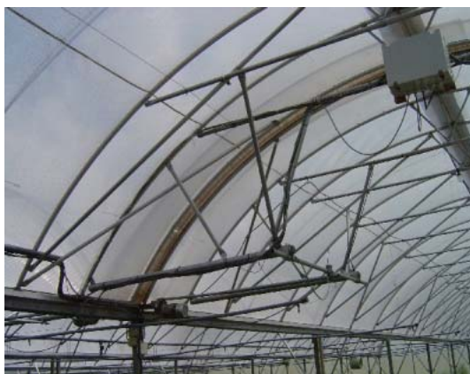
Figuur 62. Multispan rollair foliekas binnenkant (Rovero systems), kwekerij in Opheusden, dak volledig gesloten, aandrijving met motor.
