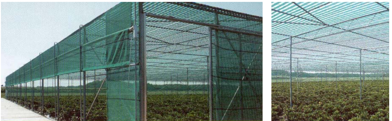
Figuur 34. Voorbeeld van een schaduwhal/ schermhal met netten in het dak en de gevels (Amevo).
