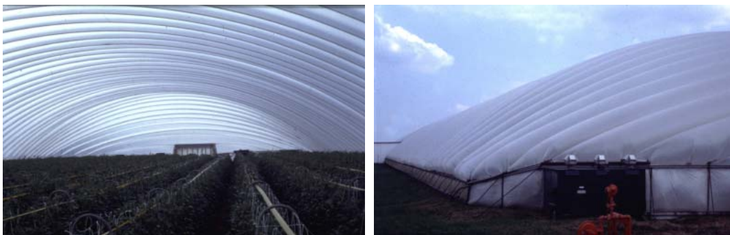
Figuur 77. Het ideaalbeeld van een foliekas totaal zonder lichtonderscheppende constructiedelen is deze kas gebouwd in de Verenigde Staten. Echter heeft deze door lucht gedragen kas weer andere nadelen (foto's Waaijenberg).
