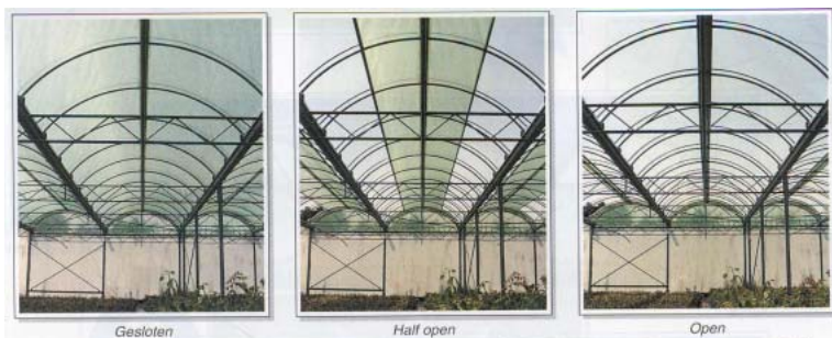
Figuur 39. Foliekas, waarbij het dek grotendeels weggerold kan worden (Rovero, type cabriolet).
