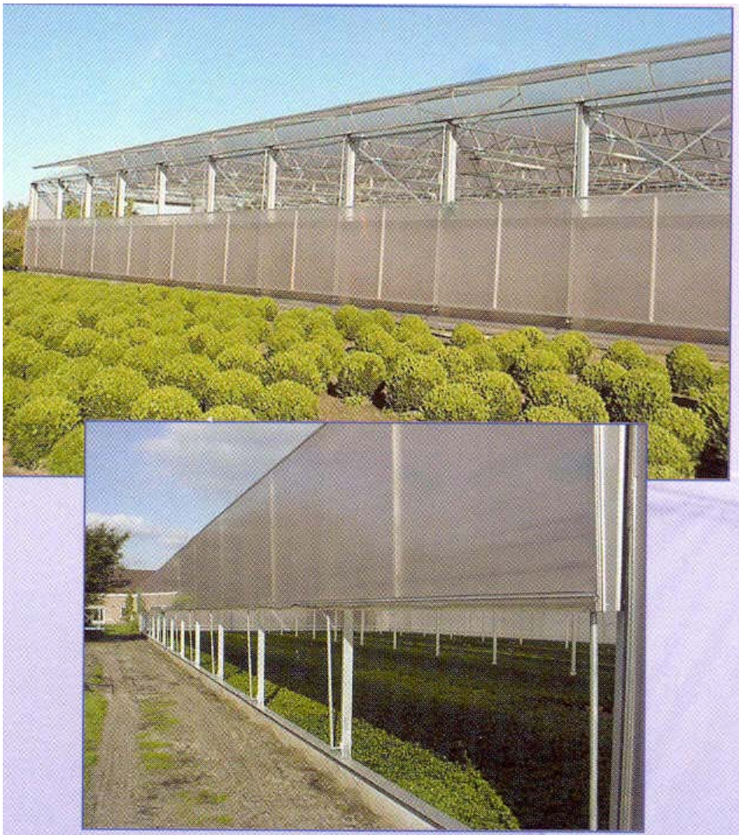
Figuur 76 Bij een kas met foliebekleding is het technisch éénvoudig om grote ventilatieopeningen te maken met name in de gevels (VDH).
