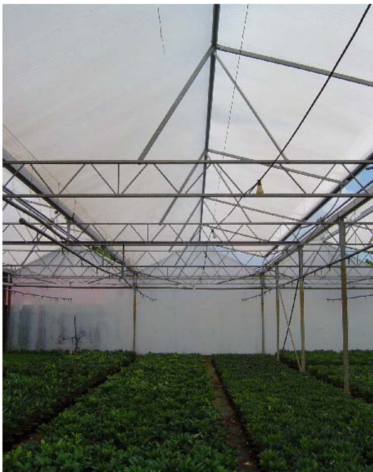
Figuur 59. Multispan foliekas met zadeldak en éézijdige nokluchting binnenkant (VDH), kwekerij in Opheusden.
