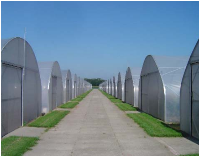
Figuur 70. Meerdere losstaande standaard folietunnels voor zaadproductie-bedrijf in Nunhem (Haalen).
