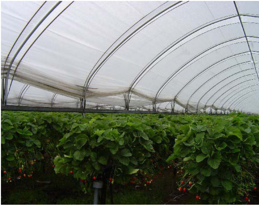
Figuur 48. Verhoogde wandelkappen binnenkant (Amevo Techniek), kwekerij in Dongen; luchting door omhoog schuiven van folie over de lengte van de kas.
