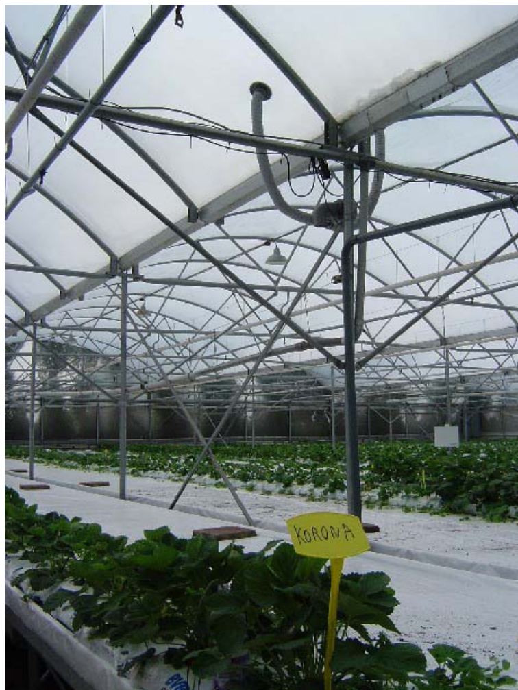
Figuur 57. Multispan foliekas met ronde kap en zijluchting met netten binnenkant (Amevo Techniek), dubbele opgeblazen folie, kwekerij in Zaltbommel.
