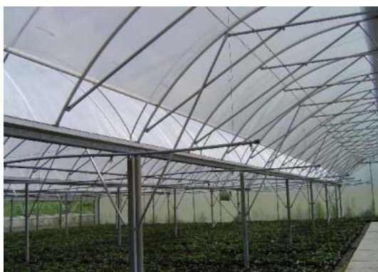
Figuur 63. Multispan rollair foliekas binnenkant (Rovero systems), kwekerij in Opheusden, dak gedeeltelijk open.
