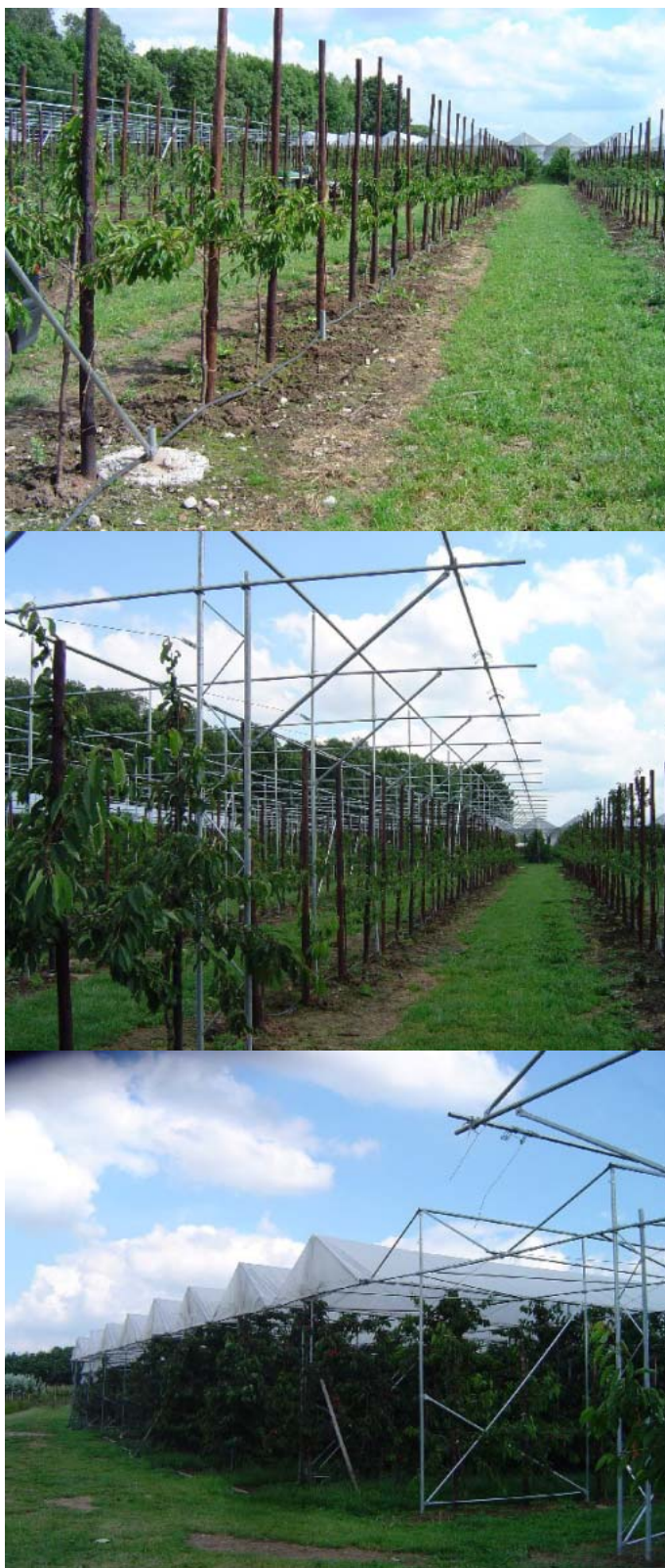
Figuur 64. Regenkappen (Rovero systems), kwekerij in Kesteren, boven: fundering, midden: staalconstructie, beneden: volledige regenkappen met folie erop.
