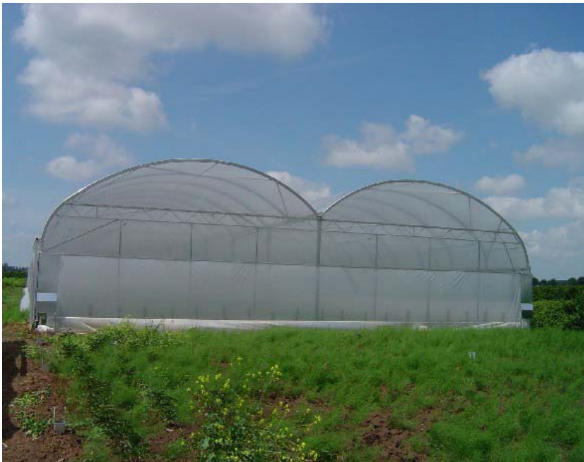
Figuur 49. Twintunnel rolkas buitenkant (Amevo Techniek), kwekerij in Kerkwijk.
