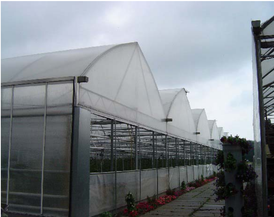
Figuur 54. Multispan foliekas met gotische kap, éézijdige nokluchting en zijluchting buitenkant (Amevo Techniek), kwekerij in Zaltbommel.
