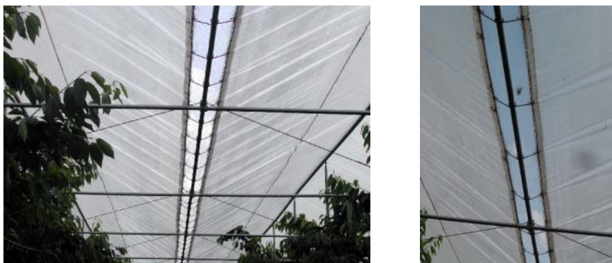
Figuur 65. Regenkappen (Rovero systems), kwekerij in Kesteren, netten worden aan elkaar bevestigd door klemmen met net ertussen (regenwaterdoorlatend).
