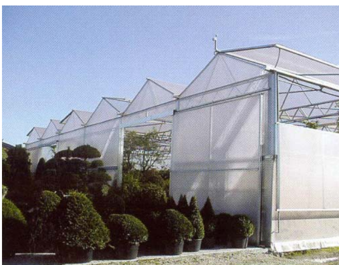
Figuur 32. Voorbeeld van een foliekas met zadeldaken, waarbij de dekfolie gespannen kan worden door het omhoogbrengen van het nokprofiel (van den Heuvel).
