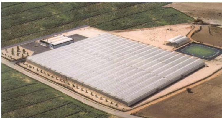
Figuur 28. Met door goten gedragen foliekappen zijn grote aanéengesloten teeltruimten te realiseren, vergelijkbaar met glazen kassen (Ininsa).
