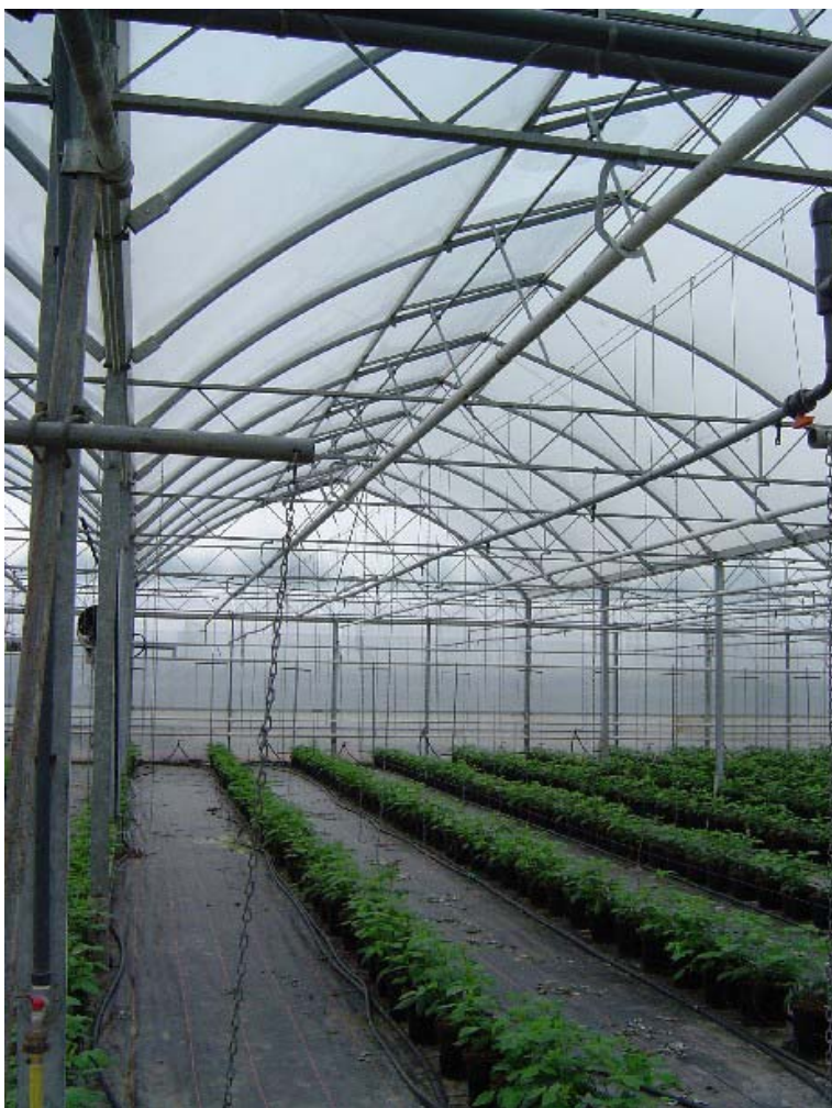
Figuur 55. Multispan foliekas met gotische kap, éézijdige nokluchting en zijluchting binnenkant (Amevo Techniek), dubbele opgeblazen folie, kwekerij in Zaltbommel.
