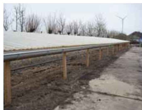
◀ fytobak aangelegd in de grond mbv vijverfolie
