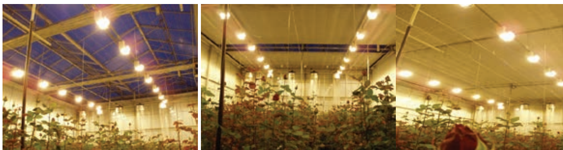
Figuur 1. Lichtafscherming buiten de donkerperiode drie schermbehandelingen. Van links naar rechts Maatwerkregel (op de Foto 10% afscherming), Lichtregel 2011(75% afscherming), Lichtregel 2014 (95% afscherming).
