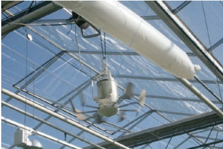
Figuur 2.1. De Aircobreeze verdeelt kaslucht verticaal over een oppervlakte van 200-250 m 2
