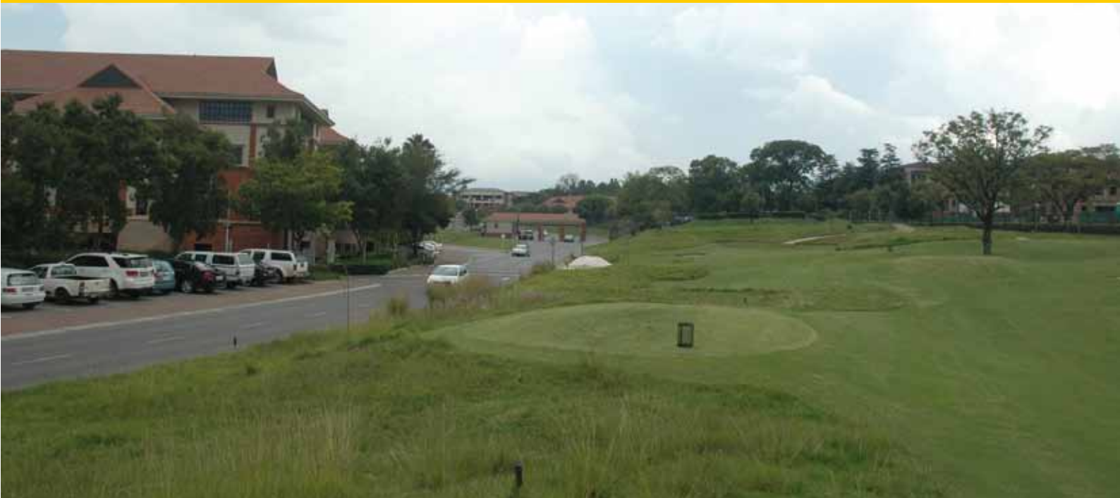
De uitlopers van de golfbaan liggen op het dak van de ondergrondse parkeergarage.
