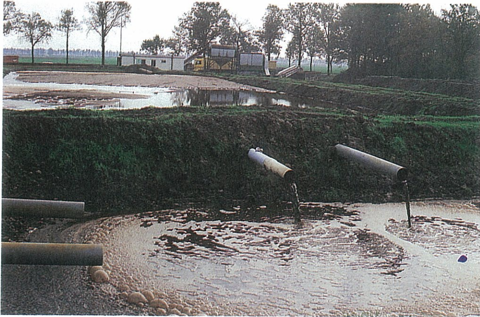
Afb. 39. Bij het wassen van peen komen grote hoeveelheden grond vrij die in bezinkings- bassins worden op- gevangen.
