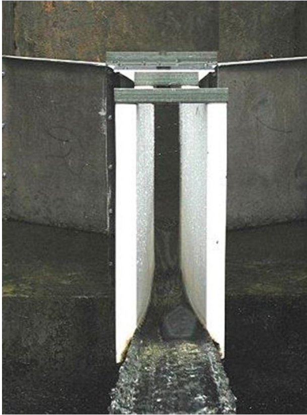
Figuur 30. Parshall flume om de hoeveelheid run off water te meten http://www.flowmeterdirectory.com/parshall.html
