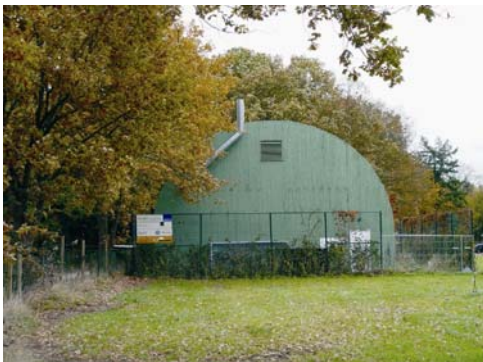
Foto 26 Opslaggebouw van de provincie Gelderland (nutsvoorzieningen).
