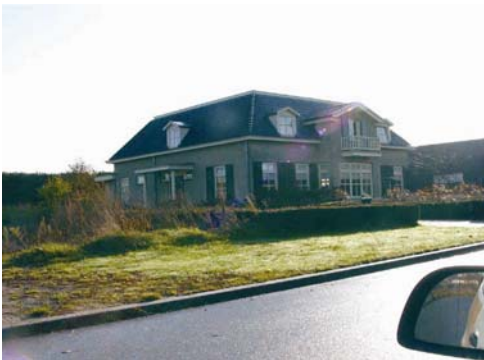
Foto 72 Een gebiedsvreemd landhuis gelegen tussen bouwmarkten en parkeerplaatsen, bedrijventerrein Apeldoorn-Noord.
