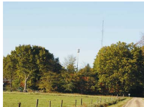
Foto 27 Zendmasten en antennes, kleine elementen (nutsvoorzieningen).
