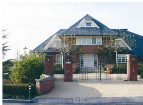
Foto 58 Nieuwbouw in gebiedsvreemde stijl (wonen in het buitengebied).
