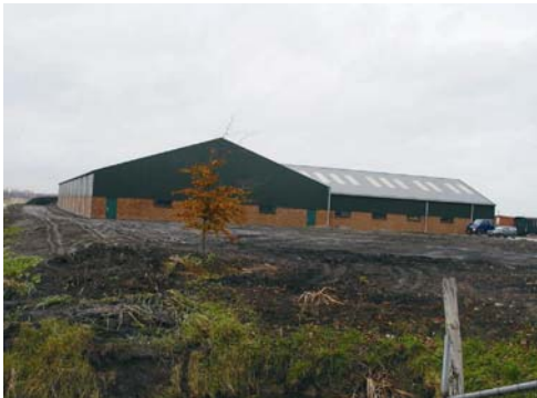
Foto 48 Zeer forse nieuwe schuur (bedrijfsgebouwen, gangbare landbouw).
