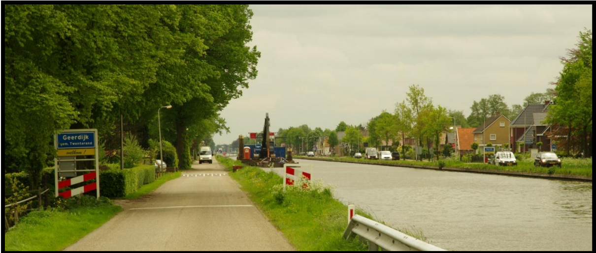
Foto 3. Geerdijk ligt aan het kanaal Almelo – Haandrik (Foto M. Ruijs)
