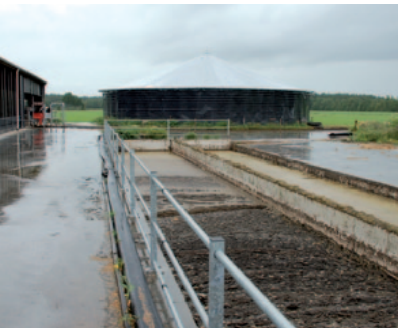
Het dubbele opslagbassin bestaat uit een dunne mestfractie (l.) en een zandfractie.
